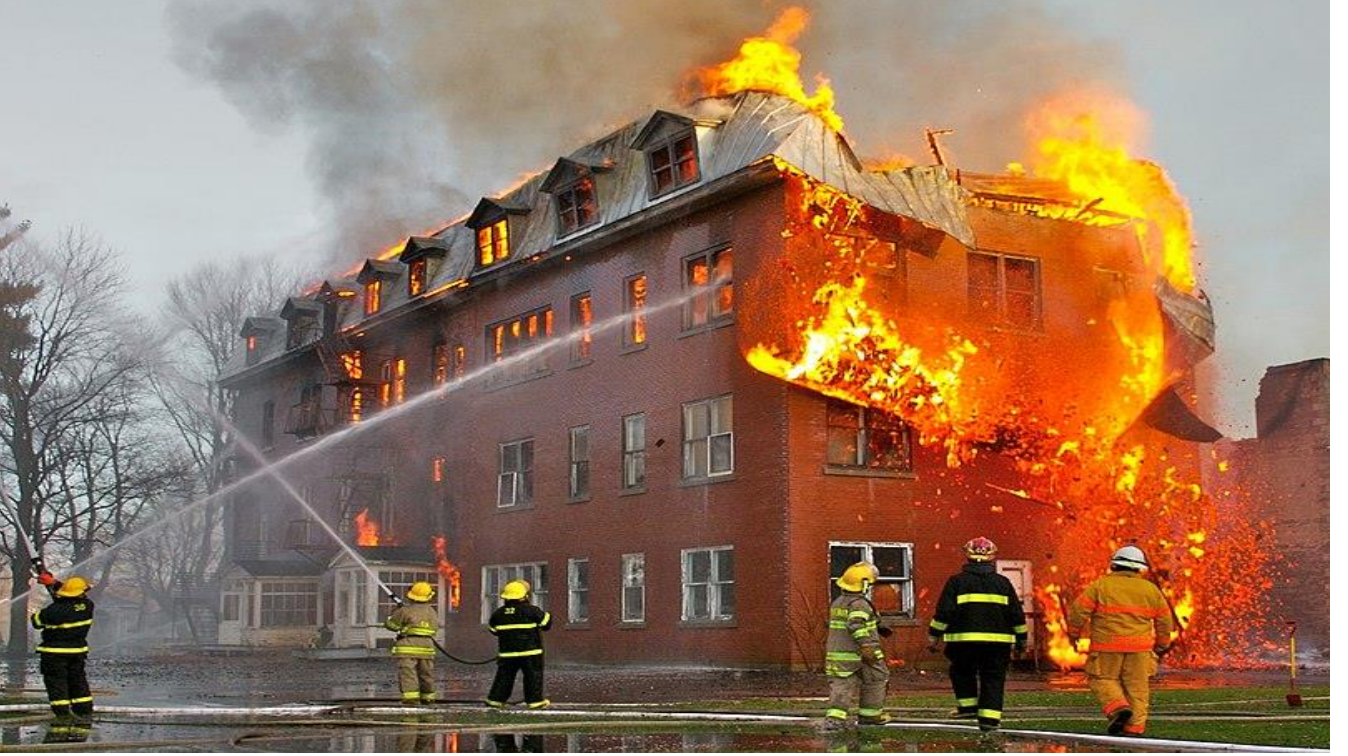
الشكل 12: عملية إطفاء لمبنى يحترق و احتمال انهيار السقف.
